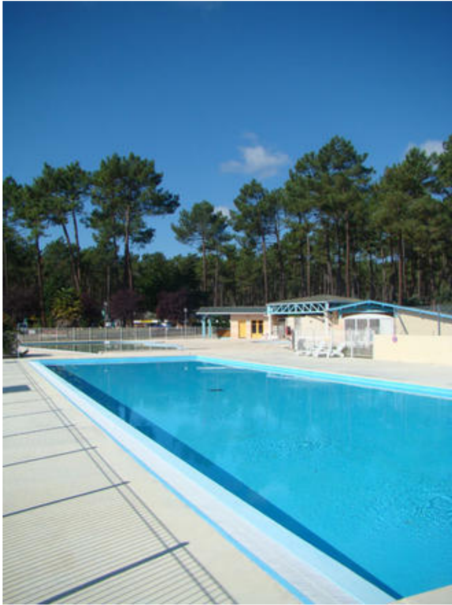
Les piscines du camping
